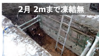
65日経過後でも表層をスコップで容易に掘削できる
