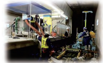
軌道内での小型機械施工
