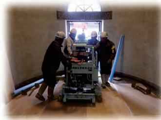
既存施設直下の耐震補強(小型機械)
