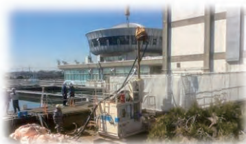
既存施設の耐震補強
