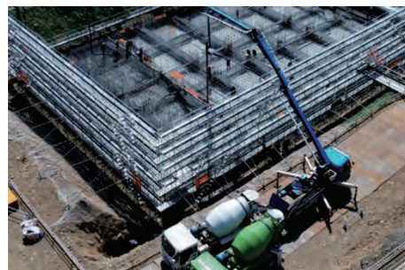
大型池上構造物(現場打ち)
