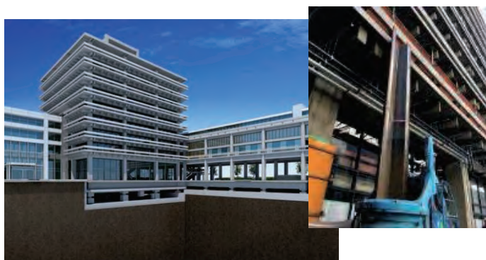
内空確保・狭隘地施工
