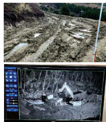
軟弱化した地盤、夜間作業においても自動走行技術で効率化を実現
