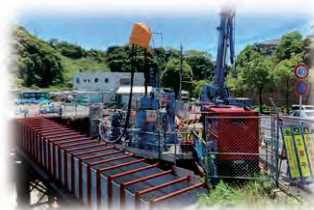
シールドマシン掘削の補助
