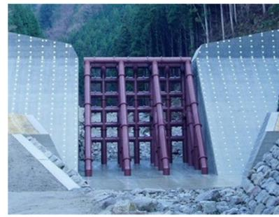
■ 鋼製透過型砂防堰堤
