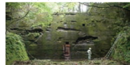
砂防堰堤の調査例
