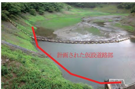
写真-5 ダム湖底部の仮設道路計画
