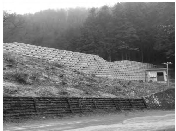
図-1 ブロック堰堤の施工事例
