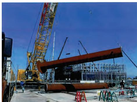
図-12 回転貫入杭施工状況 (杭吊り込み)
