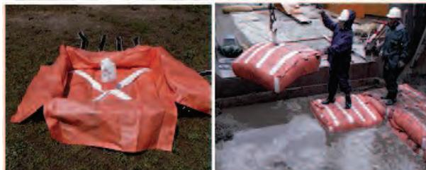
写真-1 D・Box-LS（左）と施工状況（右）
