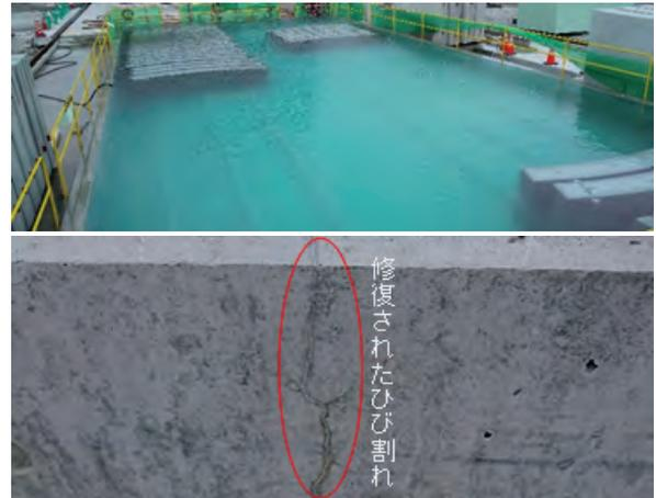
写真-6 実構造物ひび割れ修復実証実験
