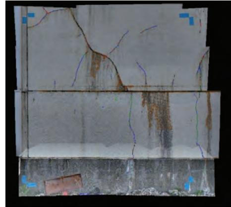
図-3 損傷の検出結果
