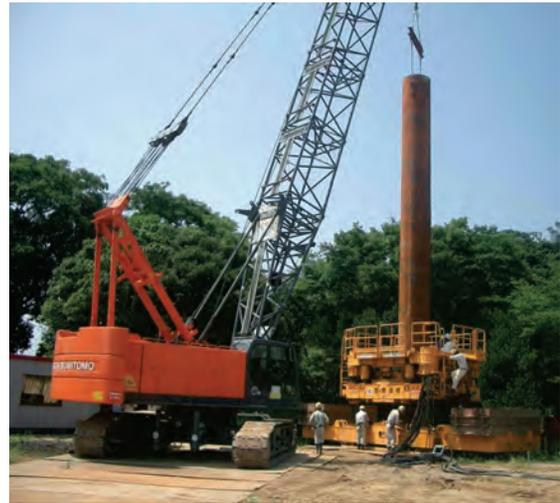
図-4 施工機械（全周回転機）
