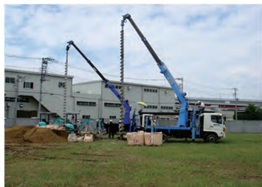
写真-1 SST 工法による施工の様子
