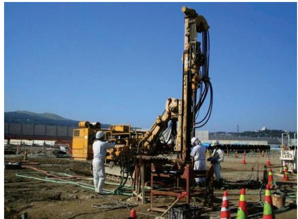
写真-13 ロータリーパーカッション式ボーリングマシンによる削孔状況
