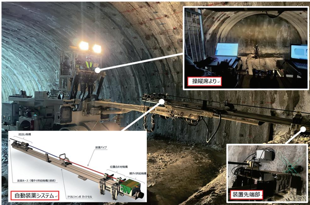
写真-11 現場実証試験の様子（無人の切羽）
