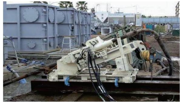
写真-10 斜め施工機械
