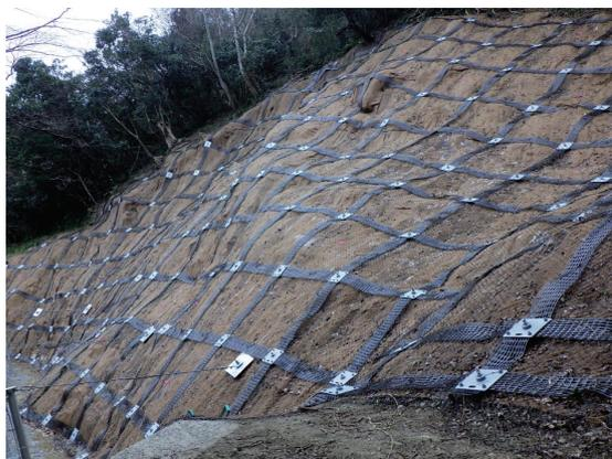
図-2 ジオグリッドと金網を併用した地山補強土工法（本工法）
