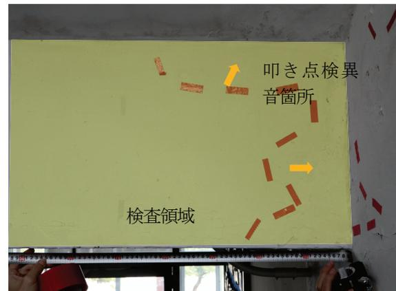
写真-2 階段部内壁-2 (A棟) : 階段の天井梁部で、仕上げモルタルの塗布箇所。赤色のテープの右、上部分で異音があり、浮きが生じているものと考えられる
