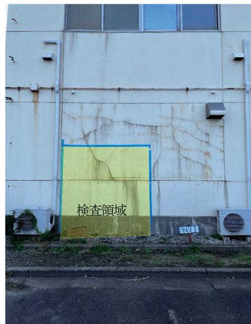
写真-3 外壁-1 (B棟北側) : 表面は凹凸がある仕上げモルタルが施工されており、2m間隔で水平方向の継ぎ
