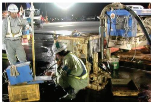
写真-2 注入管リフト装置
