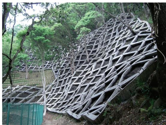
図-1 地山補強土工法の一例（法枠工）
