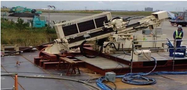
写真-11 削孔・圧入兼用機
