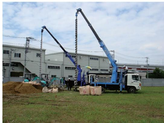
写真-1 SST 工法による施工の様子
