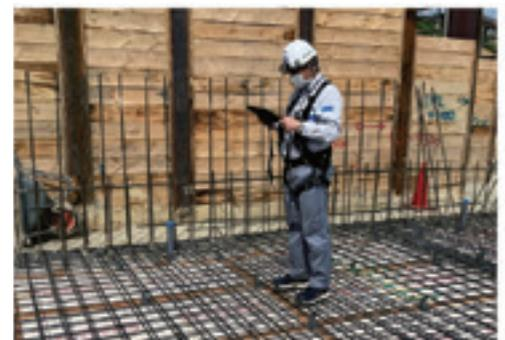
従来の鉄筋出来形計測は、測定箇所毎に対象の鉄筋にマーキング・スタッフの準備が必要でしたが、本システムでは市販タブレット(iPadPro)のみで検査を行うため、手間のかかる準備作業から解放され、1名での検査が可能となります。弊社において従来の検査方法と時間比較をした際には、作業時間を約50~70%短縮することができました。
