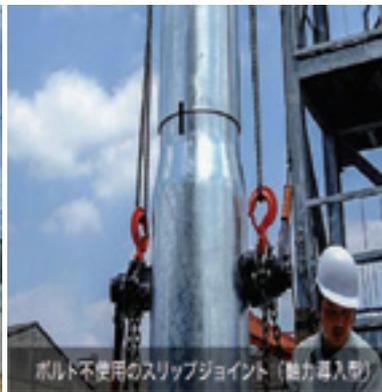
大臣認定を取得した軸力導入型の高尺分割式ポール。
