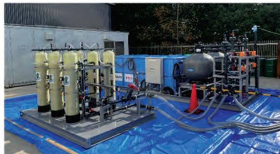
図 11 PFAS 汚染土壌浄化システムイメージ
