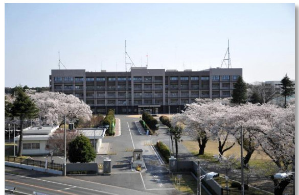
写真-1 陸上自衛隊施設学校庁舎 (北関東防衛局広報第82号(平成27年3月発行)から転載)
