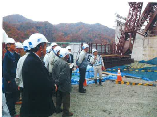
（生コンプラント説明状況）
