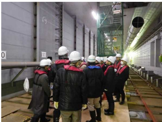
写真-5 沈埋函内部の見学
