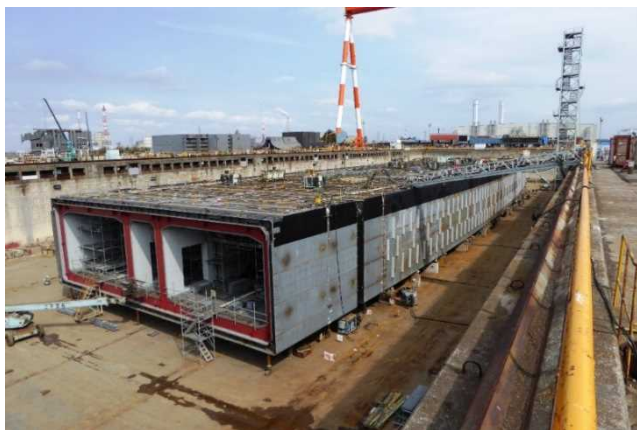
写真-9 ドック内大組立工程状況 (写真提供：(株)三井E&S鉄構エンジニアリング)
