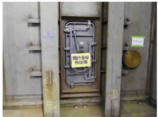
写真-6 沈埋函バルクヘッド（仮壁）部（内部）
