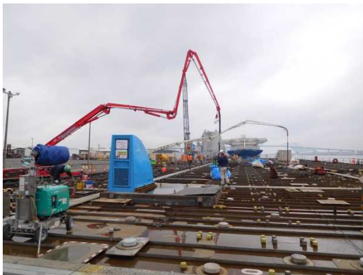
写真-3 コンクリート浮遊打設状況（沈埋函上部）
