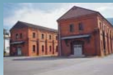
呉地方総監部 被服倉庫群
